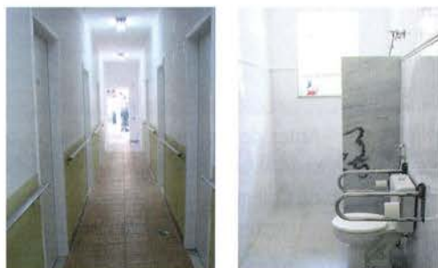
Corredor com corrimão e luz de emergência (esq.) e banheiros adaptados no novo Pavilhão
