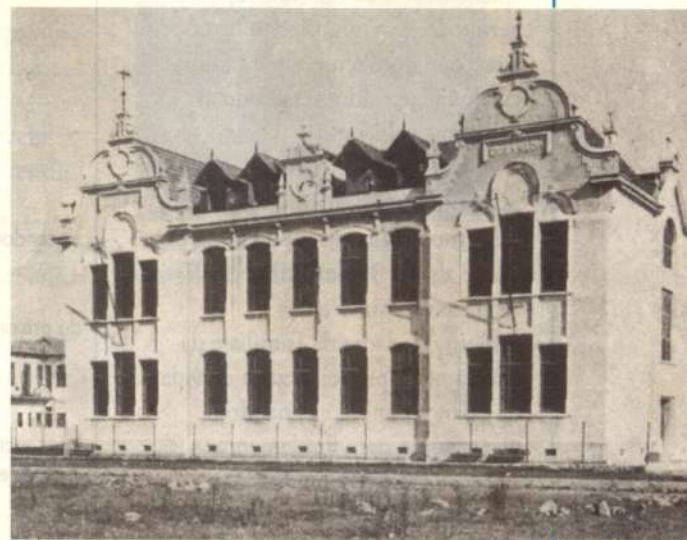
Escola Alemã, inaugurada em 1912, na rua Carlos de Carvalho, uma das primeiras construções na Esplanada do Senado
